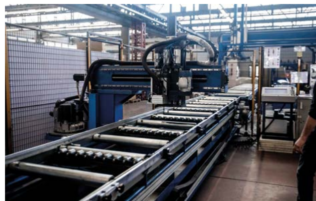
Impianto lavorazione pannelli. Panel processing plant.
