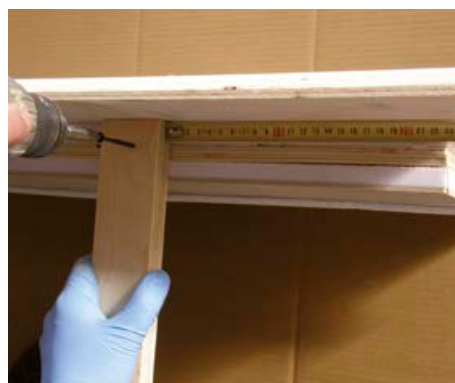
5) Verifica posizionamento distanziali
